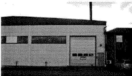
Ovan: Fasader mot nordost och Industrigatan.
