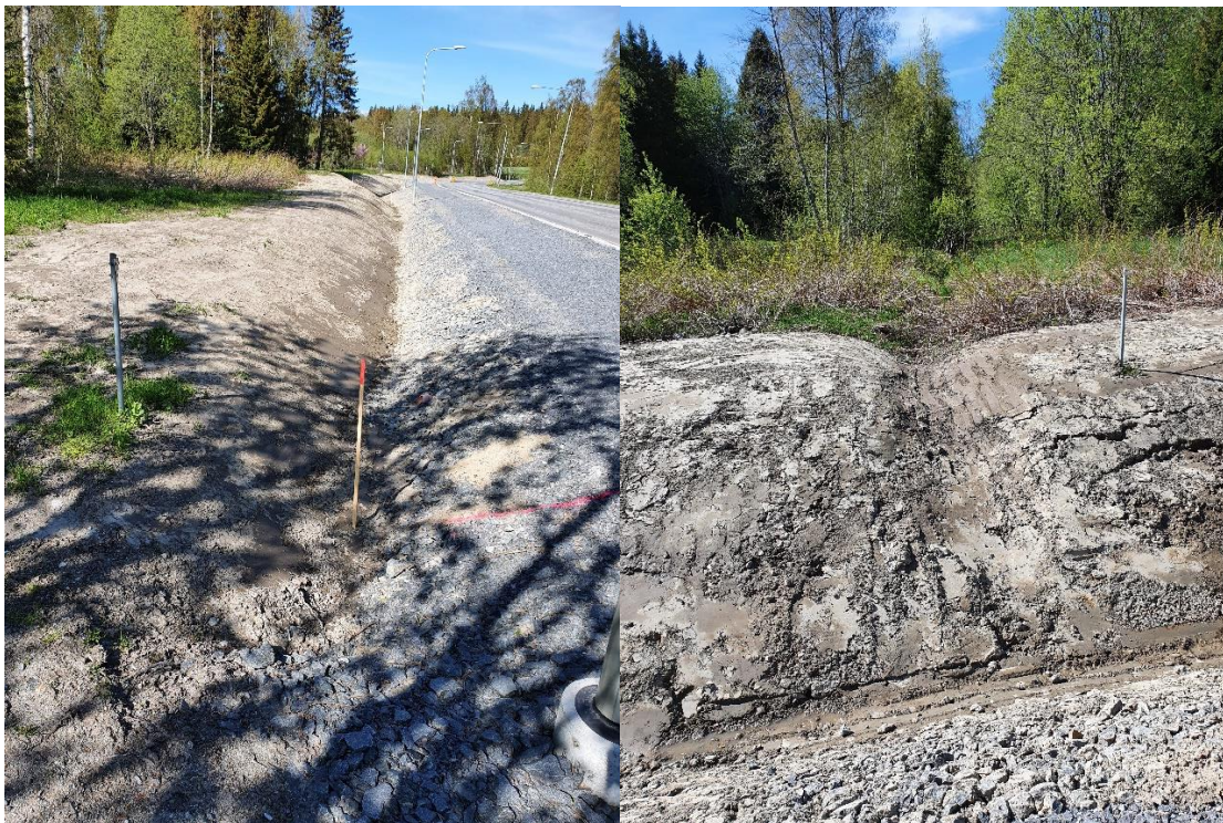
Figur 8: T v dike längs Bonäsvägen fotat från infarten till gamla torpet med dikets lågpunkt närmast i bild. T h dike som avleder ytvatten från östra delen av planområdet till diket längs Bonäsvägen.
