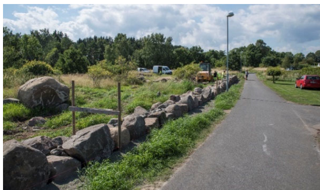
Anläggandet av ny stenmur norr om fastigheten Bianca 1. Foto: Kristianstads kommun
