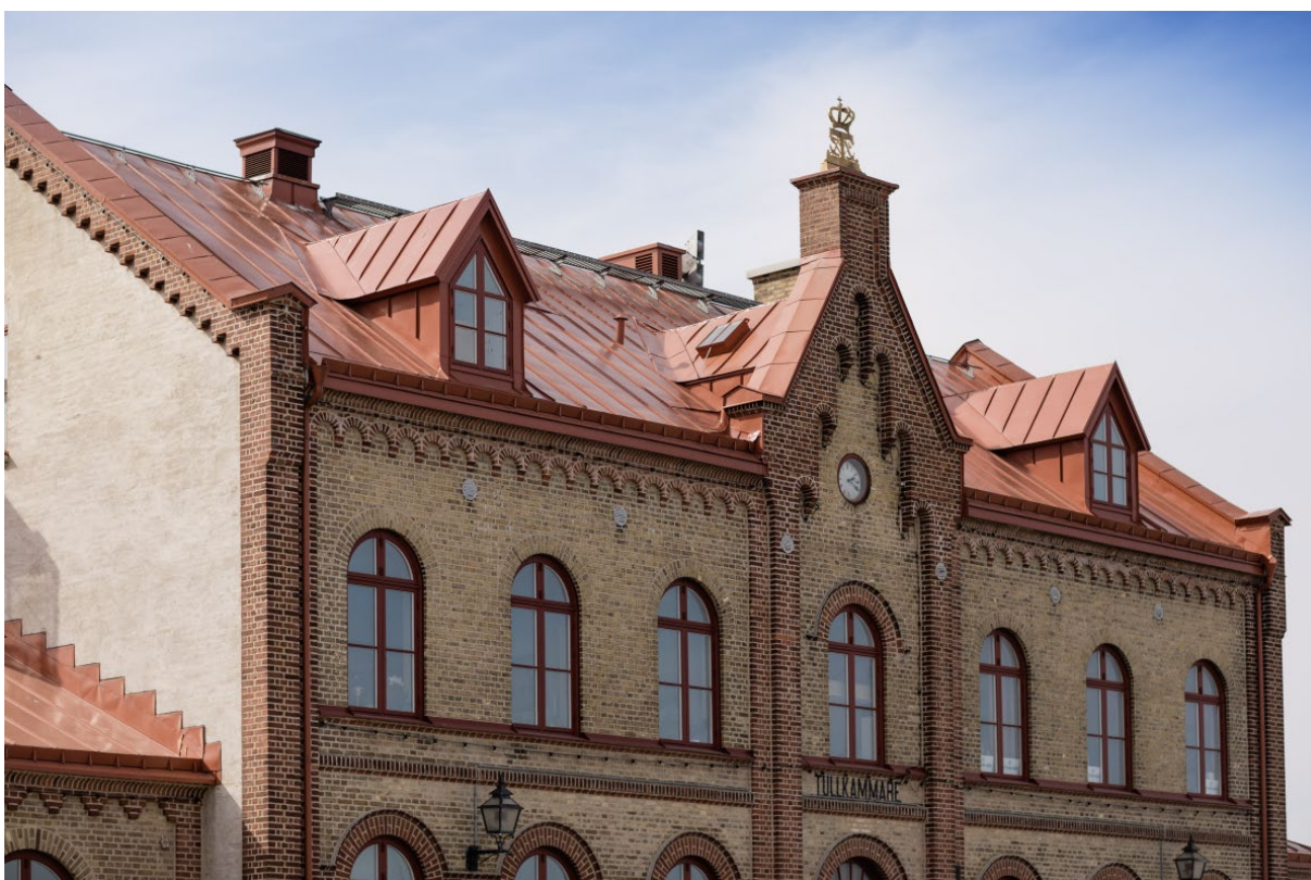
Figur 27. Bild av Tullhuset från 2020-talet. Här syns fasad mot nordost med frontespisen, klockan och den förgyllda kronan med bokstaven T. I bilden har fönstren liknande utförande som under 1950-talet. Takkuporna tillkom år 2017.
