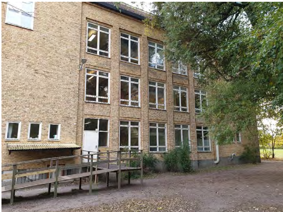
Släbroskolan, trapphusets fasad
