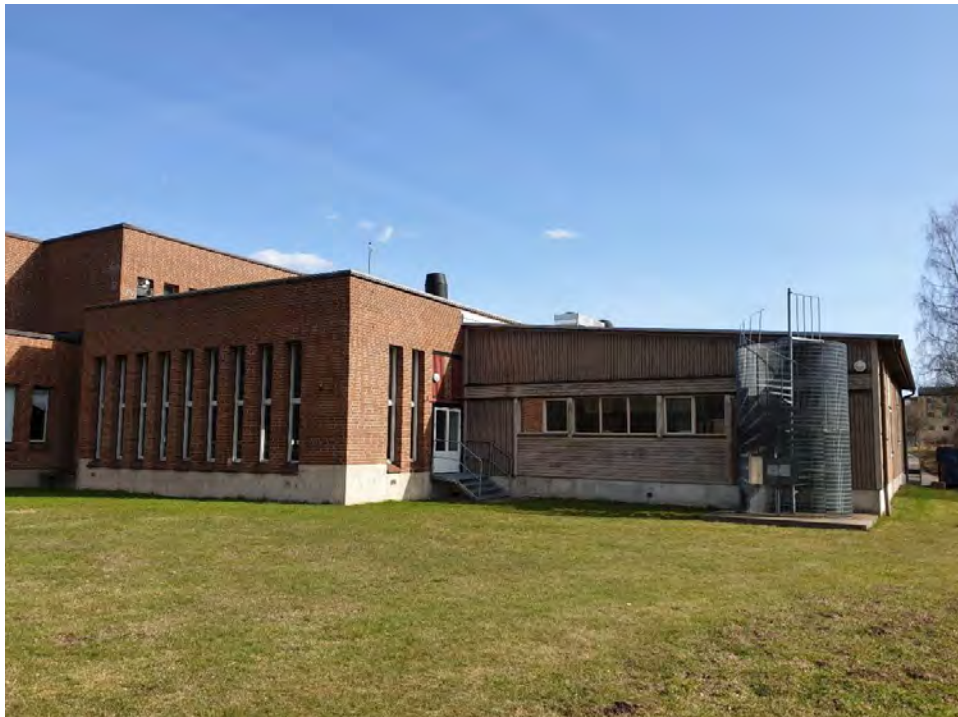
Högstadieskolans matsal med tillbyggnad tillagningskök
