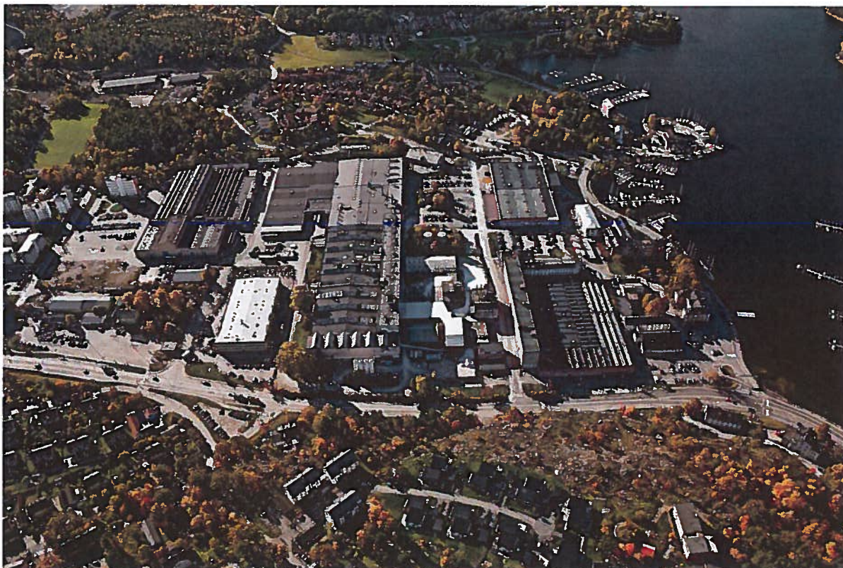
Områdets struktur och industrins karaktärsbyggnader ska sätta sin prägel på den nya Fabriksstaden. Mitt i bilden ses Sanitetsporslinsfabriken och till vänster, bak i bilden, Badkarsfabriken.
