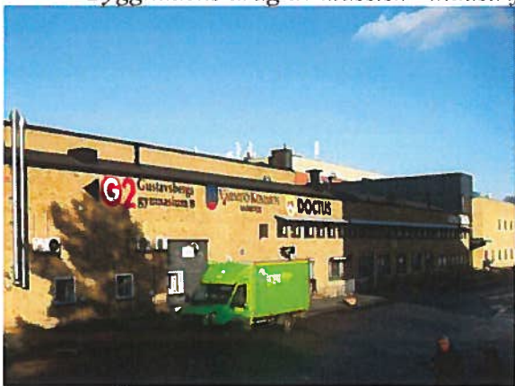
Badkarsfabriken sedd från sydväst
