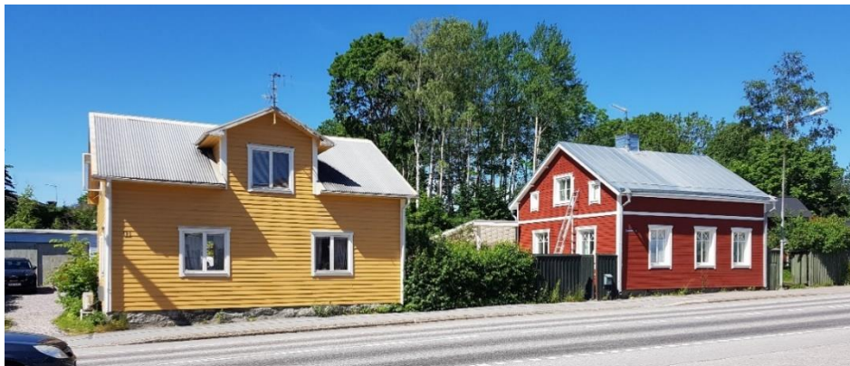
Bebyggelse på motsatta (västra) sidan av Baldersgatan. Vy från planområdet. Foto: Norrtälje kommun.
