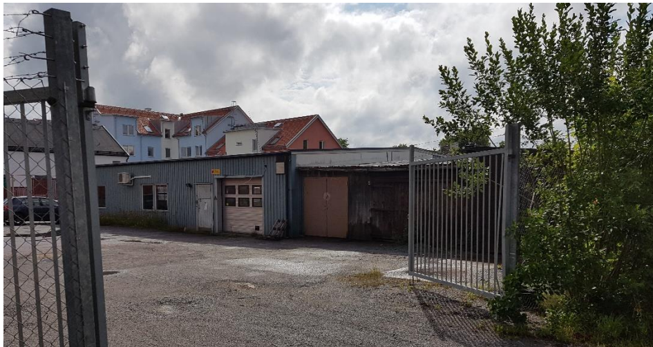
Fastighetens baksida innan rivning, vy från Odengatan. Foto: Norrtälje kommun.
