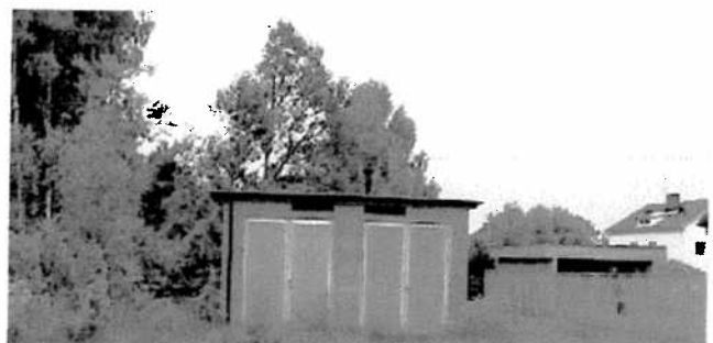
Nätstationen vid Paradisgatan. I bakgrunden syns villorna längs Karl-Johansgatan.
