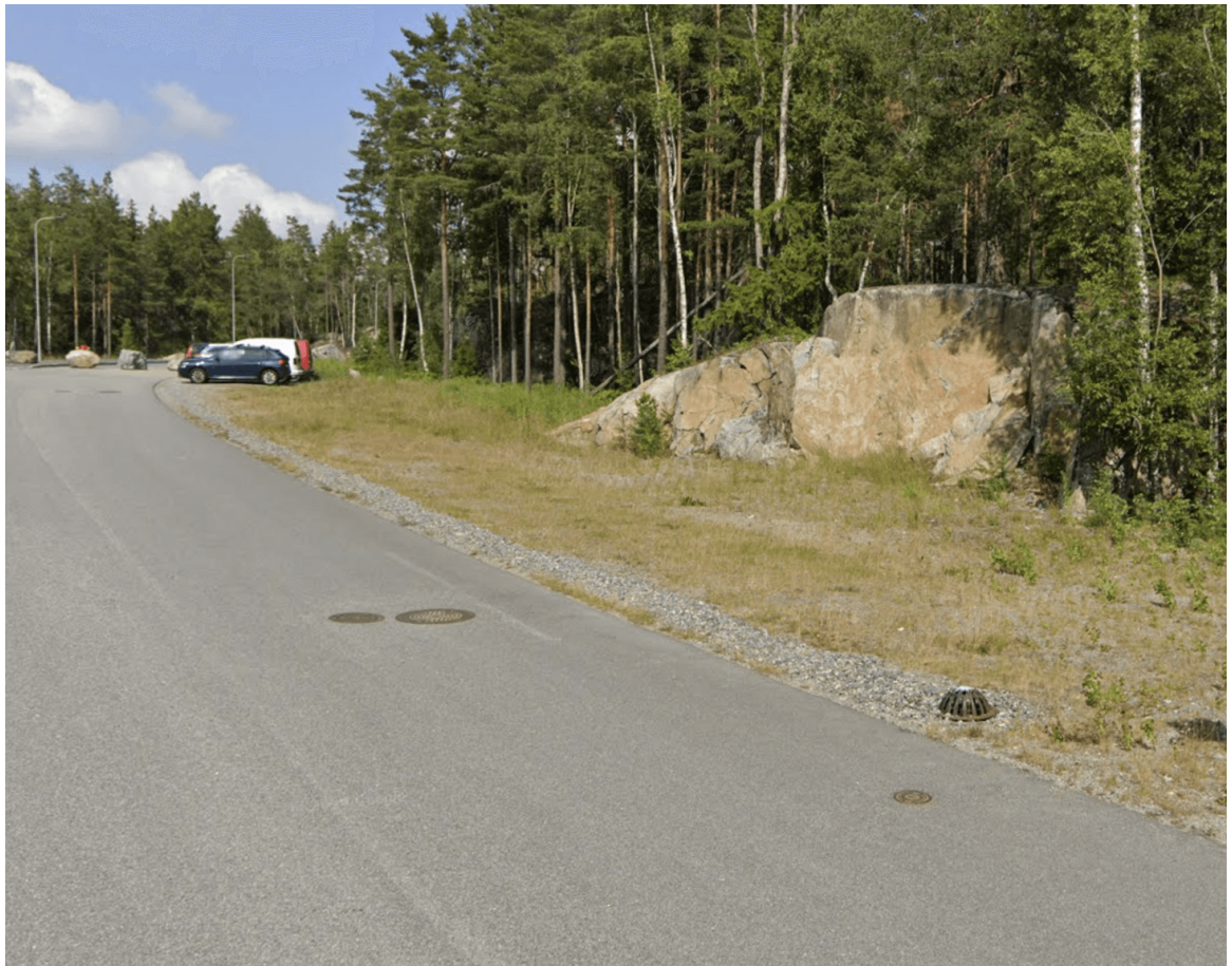
Figur 10: Stickgatan med makadamdike och kupolbrunn.
