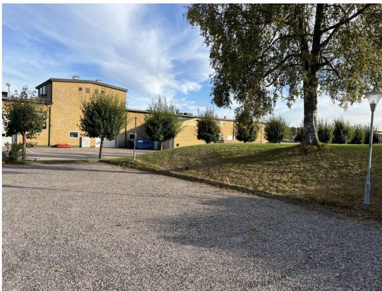
Figur 16, Bild över den östra markparkeringen inom planområdet
