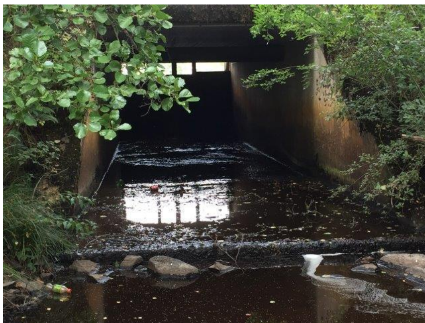
Bild 41. Bilden visar konstruktion för reglering av vatten i ER-sjön via Bjurbäcken.
