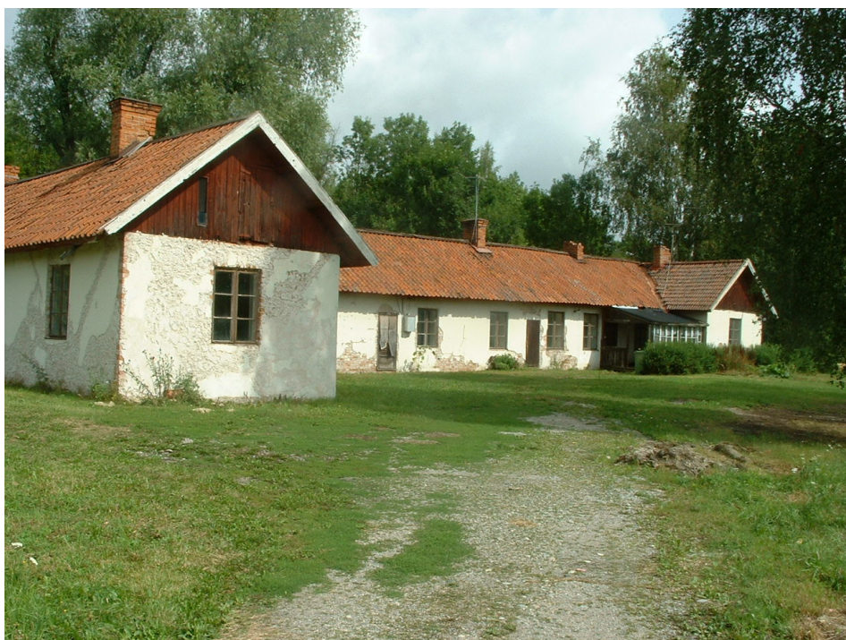
Invid Ytterselövägen ligger i dag Stallmästargården. Byggnaden föreslås rivas.
