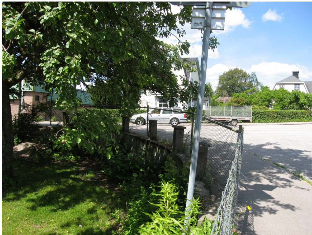
En stödmur tar upp höjdskillnaderna mellan den nordöstra delen av fastigheten och korsningen Östra Infarten - Esperedsvägen.
