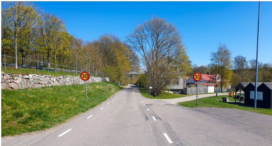
Korsning väg 812/Skolvägen.
