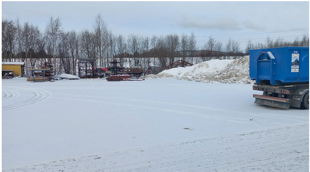
Figur 8 - Foto på befintlig markanvändning inom verksamhetsområdet. Kvartersmark för verksamhetsändamål ianspråktaget för pågående verksamhet och består i huvudsak av hårdgjord yta som nyttjas för upplag, köryta och enstaka mindre byggnader. Grönska längs med Kopparslagsbäcken kan ses i bakgrunden (angränsar mot planområdet i väst).
