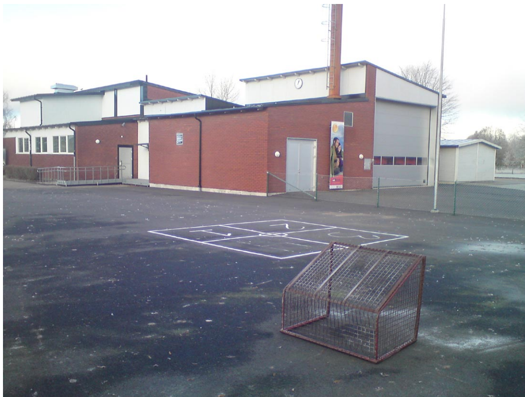
Bild på panncentralen på Ölmestadsskolan
