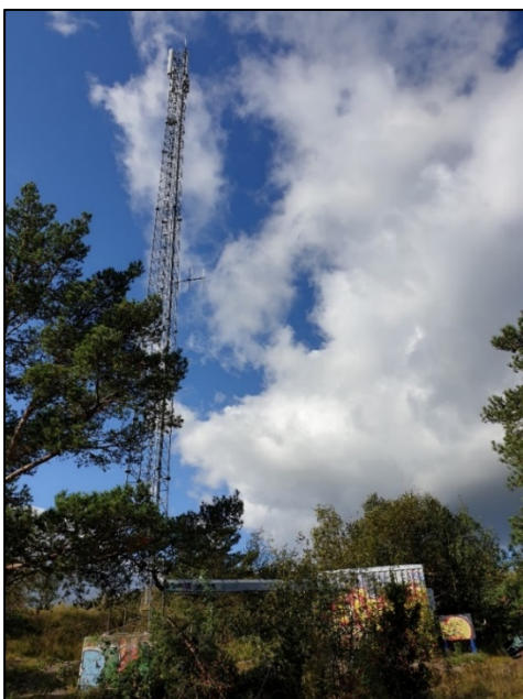
Figur 15. Mast och ansluten plåtbyggnad.
