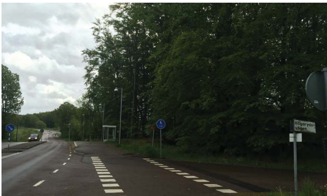
Korsningen Sandövägen/Högarydsvägen med busshållplatsen och gc-vägen
