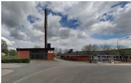
Skövde Energi:s panncentral.
