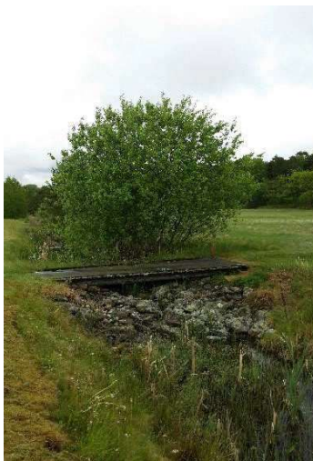
Figur 11, Exempel på uppdämning med stenröse.
