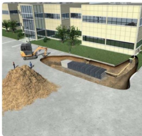
Exempel på dagvattenkassetter, placerade inom parkeringsområde.
