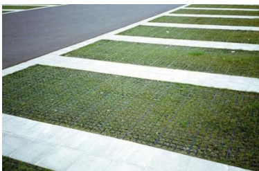
Exempel på genomsläpplig markbeläggning för parkering
