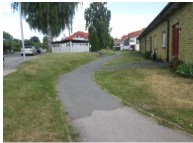
1. Suterrängbyggnad utmed Högalidsgatan, vy från syd.
