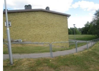
4. Lutning för angöring till park via befintlig suterrängbyggnad, vy från sydväst.
