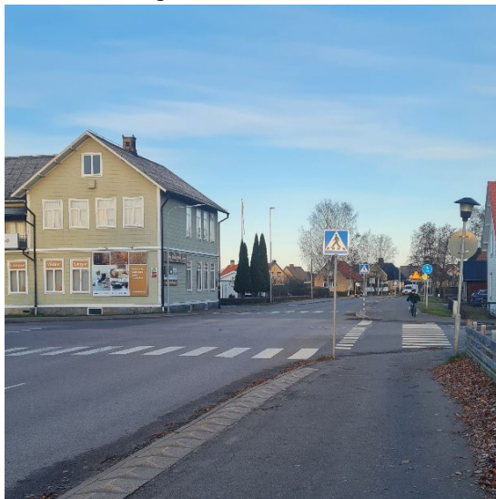
Del av gång- och cykelvägen som följer Ringvägen.
