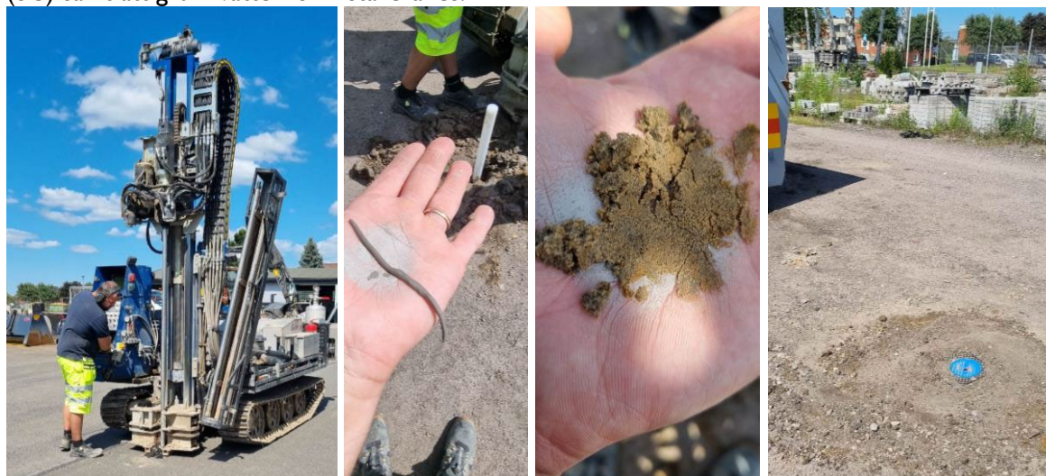
Bild 4.1 – 4.4: Bilderna visar provtagning inom undersökningsområdet. Mellersta bilderna visar skruvprov med såväl rullbar lera (fältindikation på leraförekomst) och sand från samma borrhämn. Grundvattenrör installerades och där dessa finns inom köryta kapades rören nedan markytan och försågs med ett mindre brunnsluck, en så kallad dexell.
