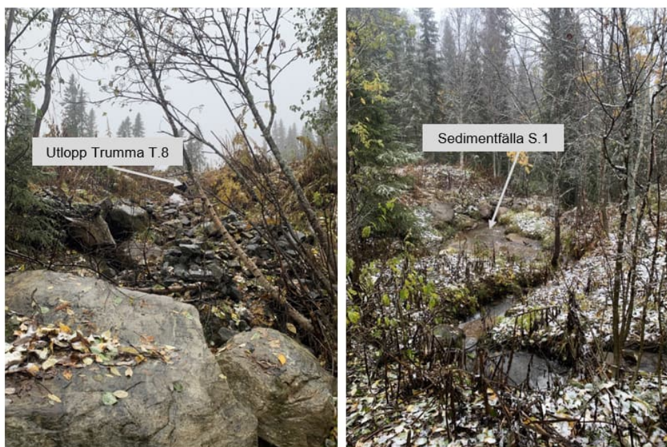
Figur 23. Utlopp från trumma T.8. Till vänster visas slänten direkt nedanför trummans utlopp med grovt material. Till höger visas bäckfåran mellan trumman och sedimentfällan S.1 (skymtas längst bort i bild).
