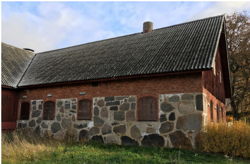
Tegel, trä och sten utgör byggnadens befintliga material. .
