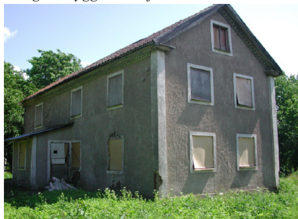
Baksidan av mangårdsbyggnaden.
