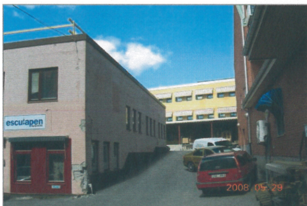
Byggnad C i förgrunden, östra fasaden, vy mot norr
