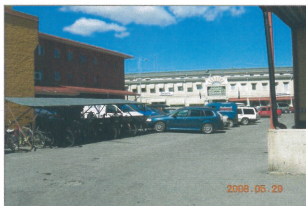
Norr om Byggnad C, vy mot norr
