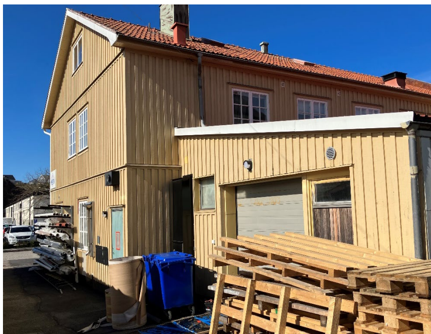
Vidbyggt lagerförråd med pulpettak. Bakgården används i stor omfattning som upplag för verksamheten.
