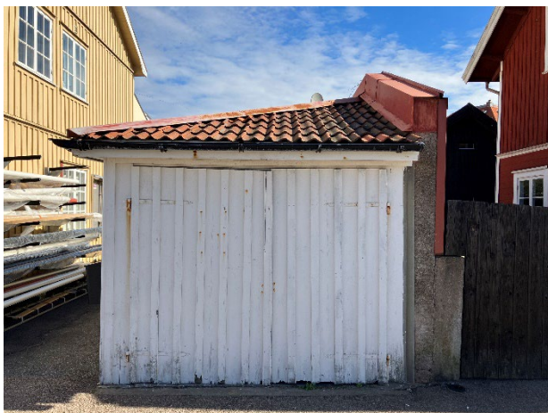
Detaljer på gårdsbyggnad. Breda portar mot Drottninggatan. Plåtklädd brandmur mot angränsande fastighet i söder.
