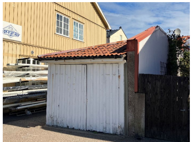
Detaljer på gårdsbyggnad. Breda portar mot Drottninggatan. Plåtklädd brandmur mot angränsande fastighet i söder.
