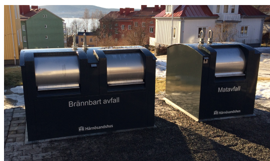
Underjordsbehållare vid Lindstedtsvägen.
