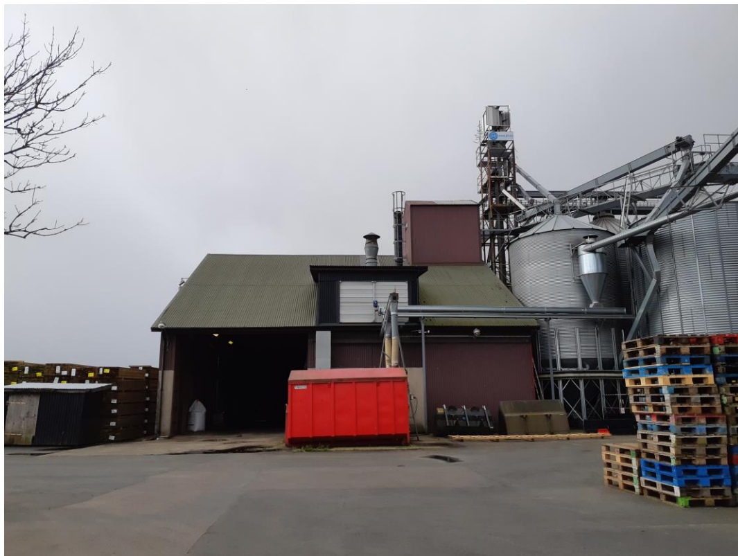
Huset i rött utgör befintlig torkfunktion, befintlig siloanläggning t.v i bild
