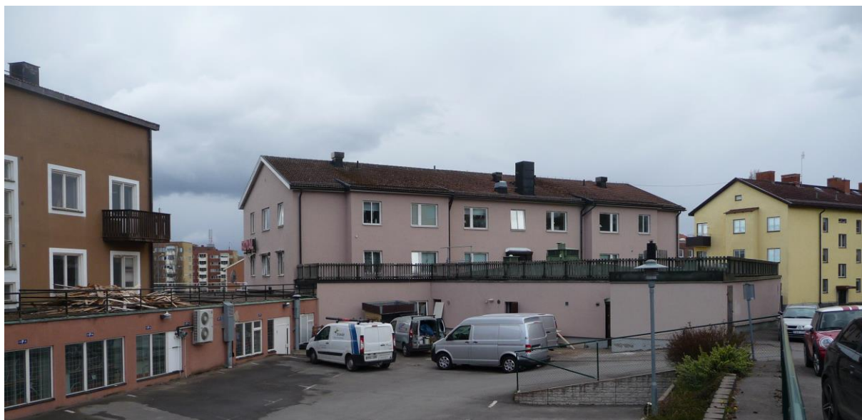
Terrassgatan till höger, bebyggelsen inom Spiran 2 till vänster samt planområdet i fonden framför trevåningsbyggnaden.
