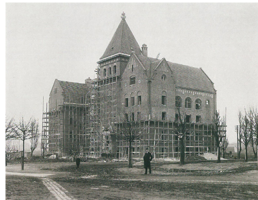
Det nya läroverket under uppförande.
