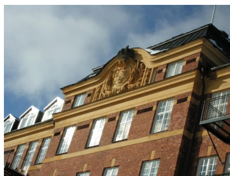
Rött mönstermurat tegel, gula slätputsade dekorativa partier, slätputsad profilerad takföt, valmade tak, falsad svart plåt på tak vitmålade och småspröjsade fönster är några av kasernernas karaktäristiska drag. Foto: Värmlands museum.
