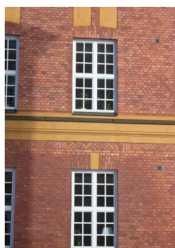
Rött mönstermurat tegel, gula slätputsade dekorativa partier, slätputsad profilerad takföt, valmade tak, falsad svart plåt på tak vitmålade och småspröjsade fönster är några av kasernernas karaktäristiska drag. Foto: Värmlands museum.
