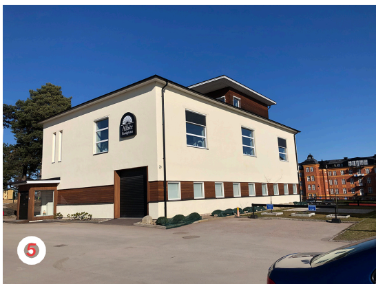
Den f.d. värmecentralen som byggts om- och till och inretts som kontor.
