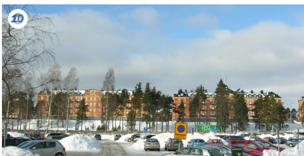
Monumentala kasernbyggnader från öster (ovan) och mot kaserngården (till höger). Foto: Värmlands museum.
