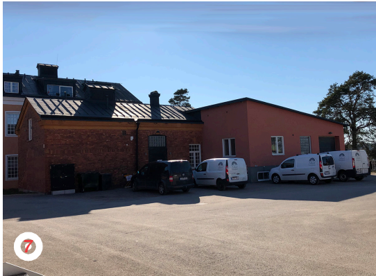
Undercentral värme som används till verkstad idag.
