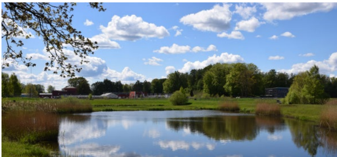
Figur 25. Reningsverket och kontors- och laboratoriebyggnaden intill Sjörrödsdammarna.
