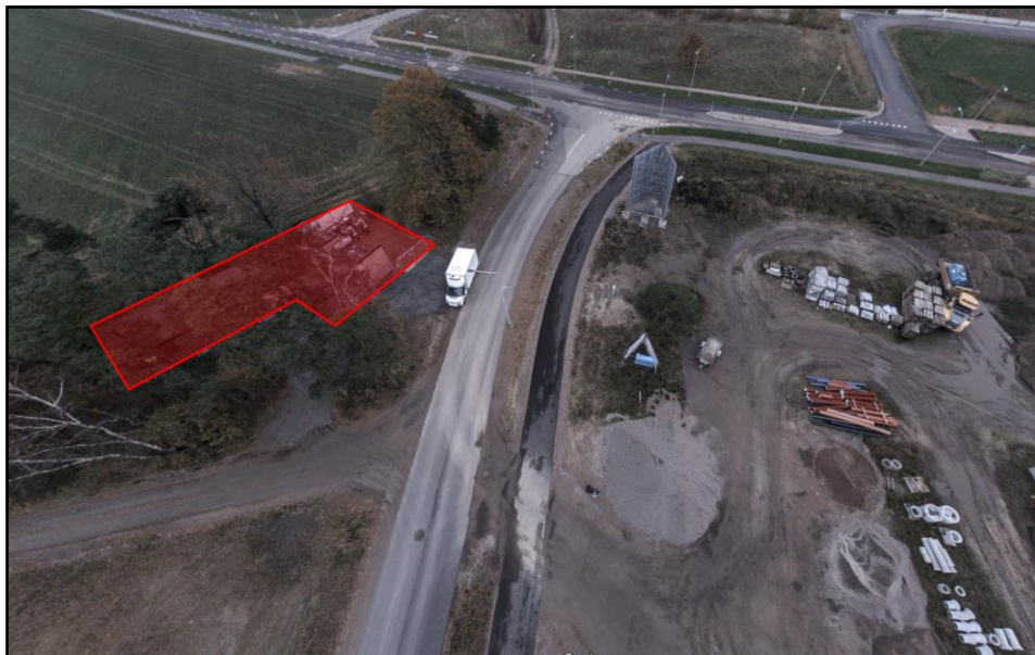
Figur 4. Vy från ovan/nordväst där aktuell station är markerad med rött [4].
