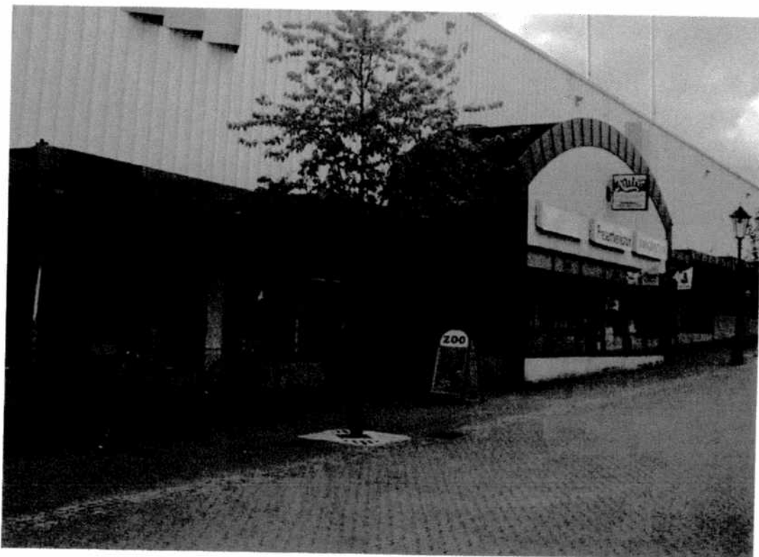
Entrébyggnaden mot Köpmangatan planeras utökas vid framtida ombyggnad för galleria.
