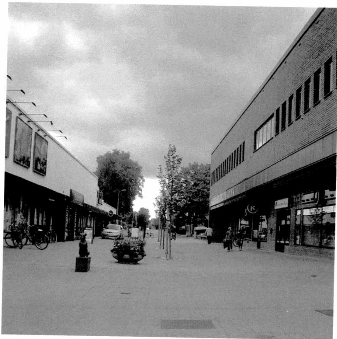
Till vänster Konsumbyggnadens fasad mot Södergatan. Här planeras ett nytt entré- och trapphus utbyggt på gatumark.
