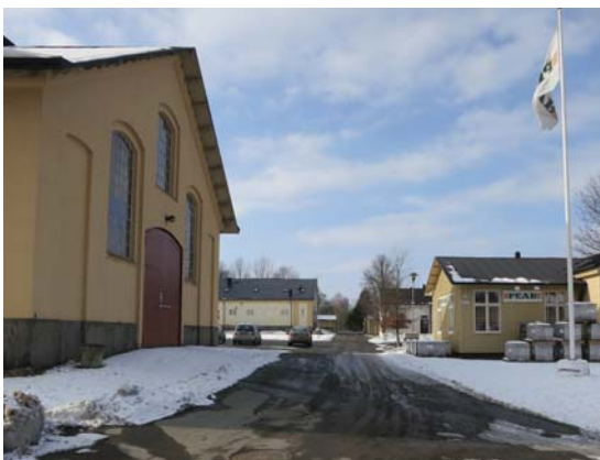
Befintlig gata in i kvarteret Remonten, sett från öster.
