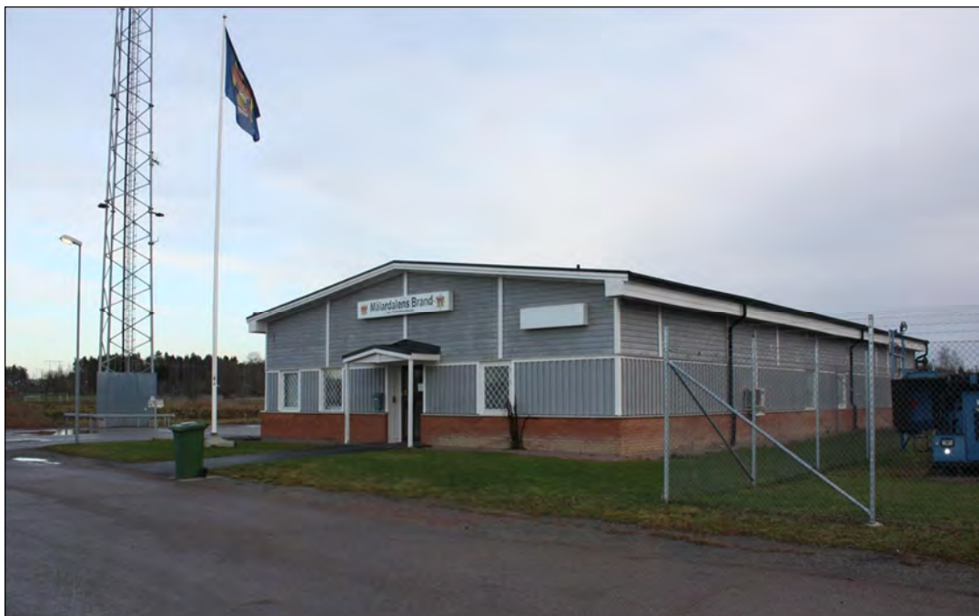
Figur 3. Mälardalens Brand- och Räddningsförbunds brandstation i planområdets norra del.
