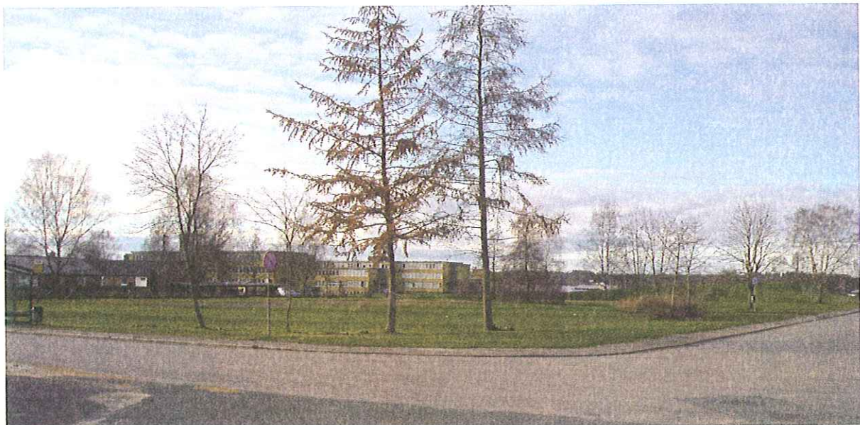
Klöverängen, vy från östlig riktning. I bakgrunden syns Östboskolans gula byggnad och till vänster radhusområdet
