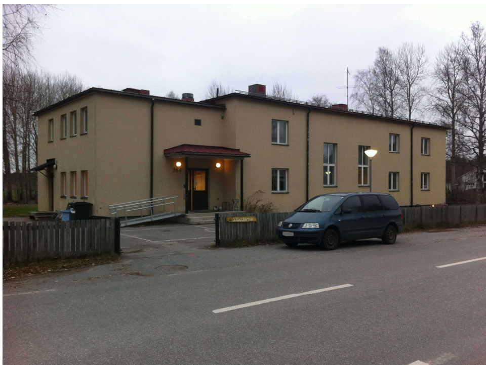
Befintlig byggnad på fastigheten Sätra 2:94
