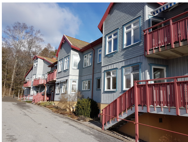
Befintlig byggnad inom planområdet
