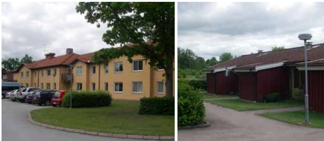
Till vänster, del av servicehemmet och till höger radhusen.
