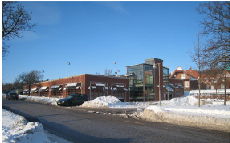
Parkeringshuset i planområdets sydöstra del.
