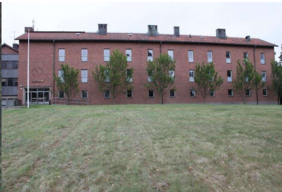
Byggnad 1, fasad mot nordväst.
