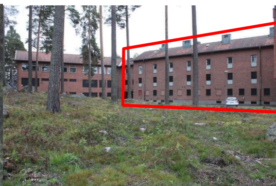
Byggnad 2, fasad mot nordost.
