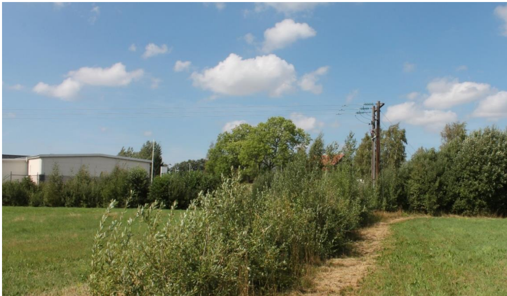
Kraftledningen söder om Borgs motor som planeras tas bort under 2019-2020.
