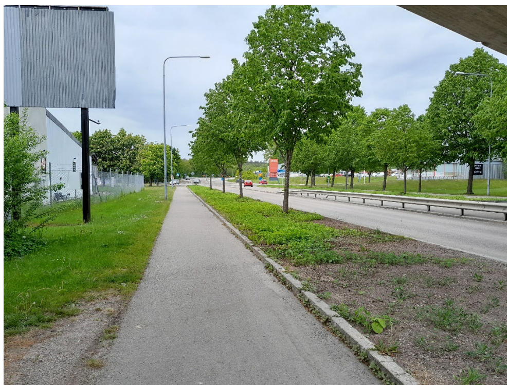
Exempel på Karlshamnsvägens separerade gångbana med kantsten av granit i anslutning till järnvägsbron över Karlshamnsvägen. Foto Planenheten 2025-05-27.
