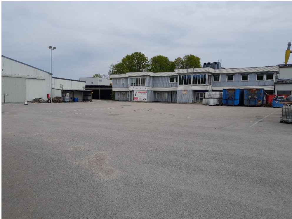
Exempel på befintlig bebyggelse i kvarteret Huven med tydlig industriell karaktär. Foto Planenheten 2025-05-27.
