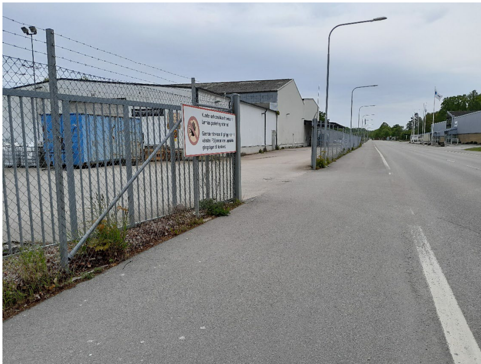
Fotografi av den södra utfarten från Kvarteret Huven 1 mot Västra Industrigatan. Foto Planenheten 2025-05-25.
