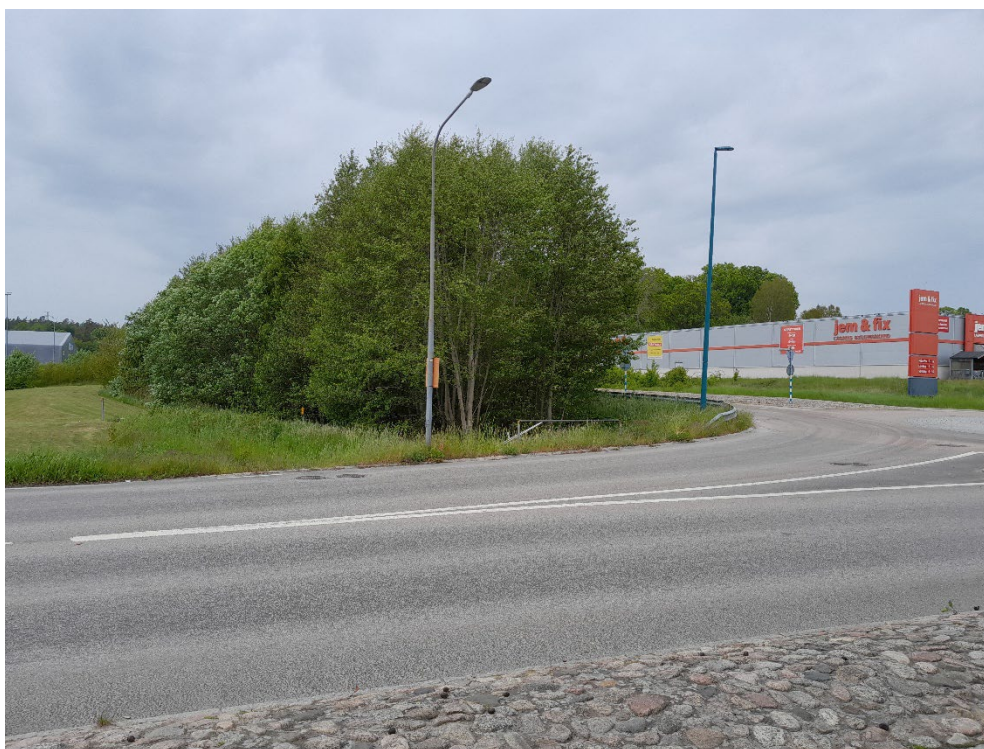
Fotografi av Sörbybäckens sträckning där bäckfåran möter Västra Industrigatan och övergår i kulvert. Foto Planenheten 2025-05-27.
