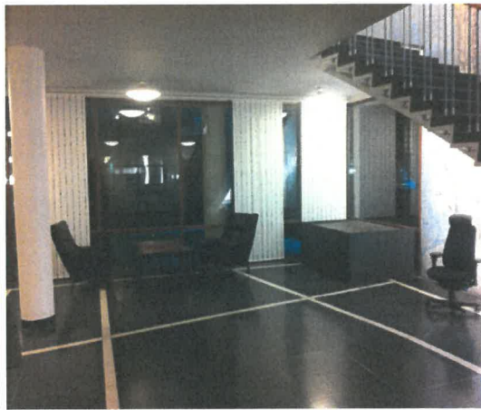
Fig. 10. Glasade dörrpartier och terrazzogolv (A). Foto Enar Nordvik
