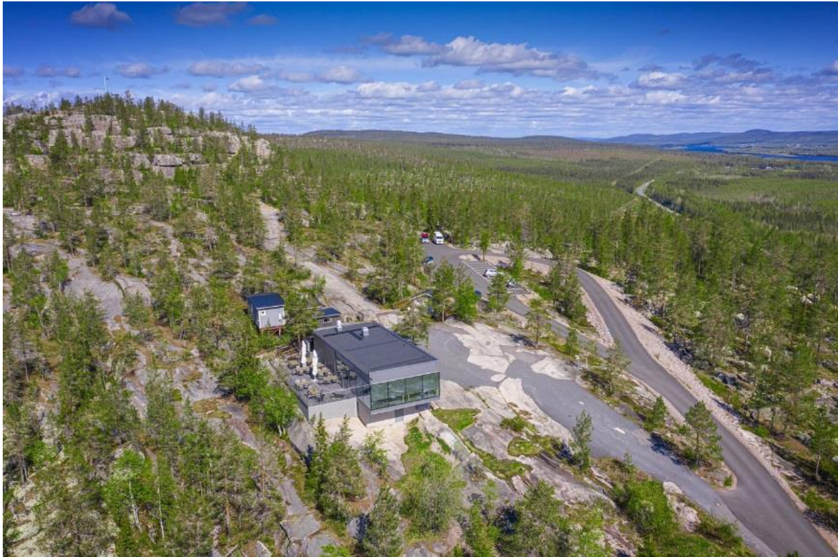
Foto av restaurangbyggnaden.
