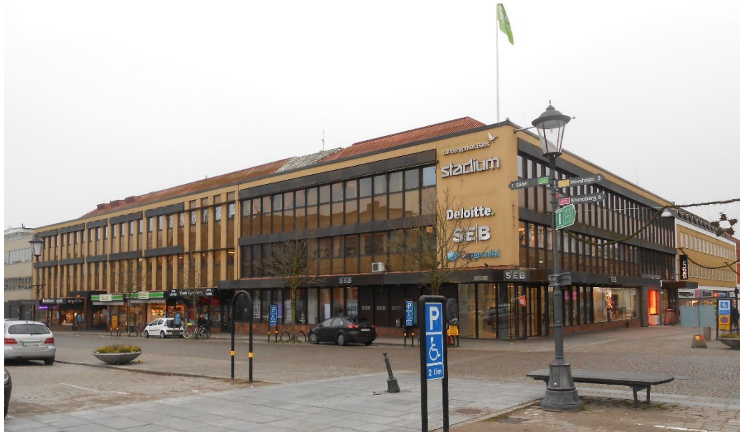
Befintlig byggnad på Unaman 9, vy från nordöst, Stortorget.
