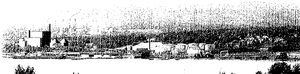
Kraftvärmeverket från Sörliden
