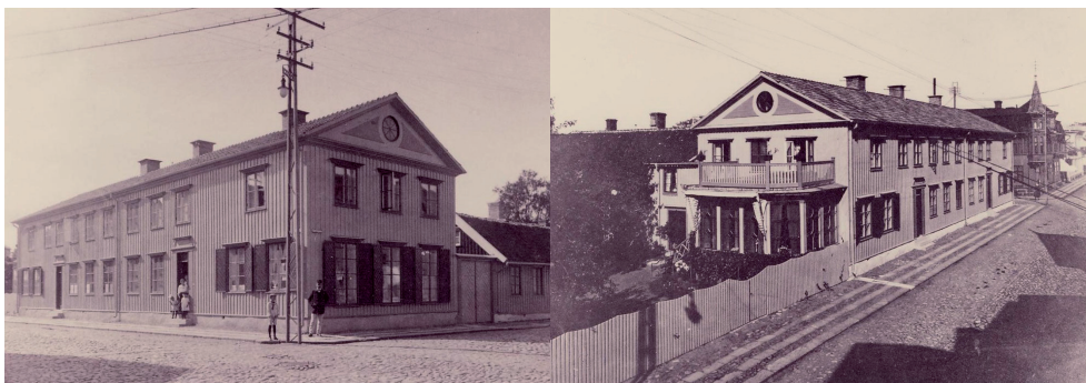
Storgatan 9. Arkivfoto från norr på 1920-talet efter påbyggnaden.
